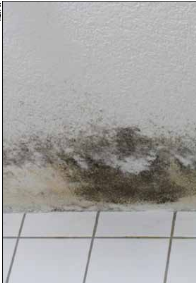
Schimmel an den Wänden ist nicht nur unansehnlich, sondern kann auch der Gesu
