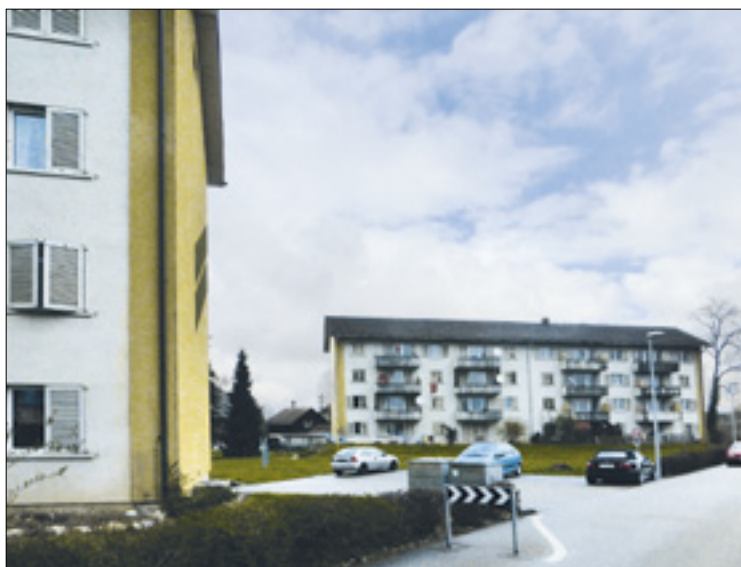
Diese Mehrfamilienhäuser brauchen eine Renovation – aber eine sozial verträgliche.
