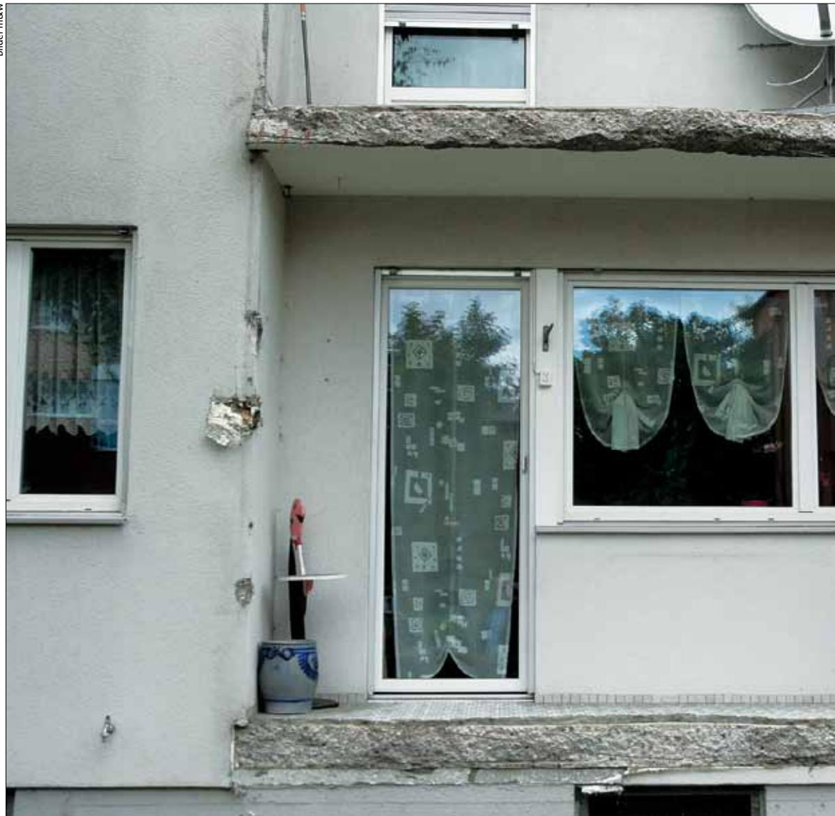
Das passiert, wenn Balkone ohne Armierungseisen eingebaut werden.
